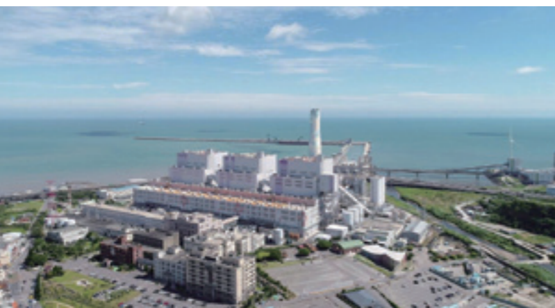
台電攜手日本三菱重工與三菱商事集團，於林口電廠推動混氫示範計畫，目標西元2030年前達燃煤混氫5%發電，以初期每日混燒1小時計算，屆時每年將減少9000噸碳排放量。
