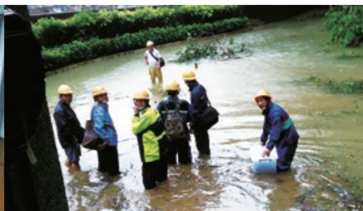
在確認烏來電廠內所有電氣設備均沒有電源後，全員決定撤離電廠展開對外求救的驚險之路。
