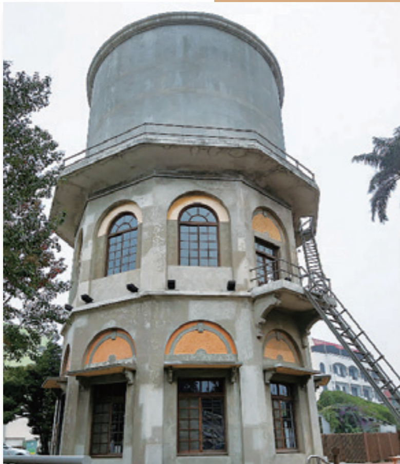
北港十角蓄水塔 駱致軒攝
