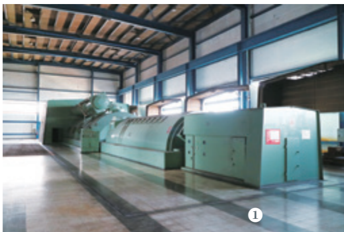
① 協和發電廠的發電機組，未來都將拆除改造。 ② 協和發電廠蜿蜒起伏的廠區道路 (林勝裕提供)。
