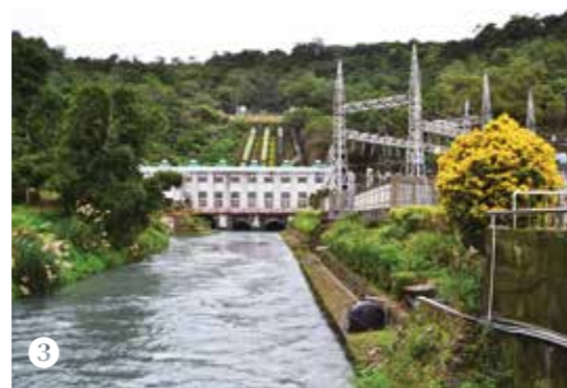
① 安農溪堤防的邊坡綠草如茵，是民眾散步的好去處。 ② 身處如此優美宜人的水岸環境，正可忘憂遠離塵囂。 ③ 宜蘭三星安農溪是源自台電蘭陽發電廠的「天埤電廠」發電後尾水所形成的溪流，故安農溪在當地人的口中曾被稱作「電火溪」。
