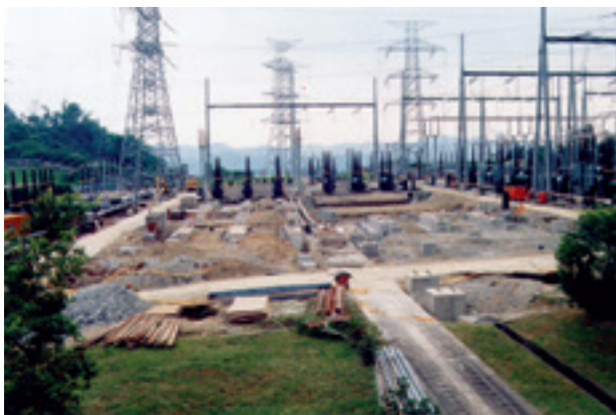
▲ 災後搶修工作中，為防止未來土壤鬆動造成損壞，開關場地基加入連梁工法，讓設備基礎扎實地打入地層中不再受震動位移。
