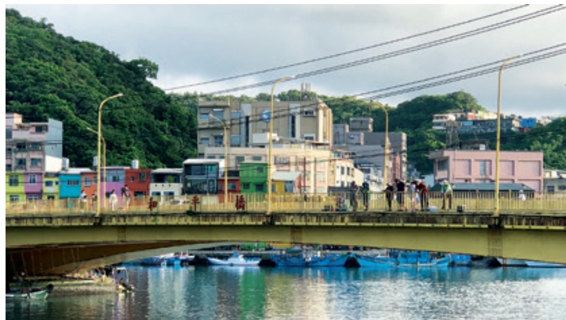
▲ 有臺灣第一座跨海大橋之稱的「和平橋」，長度僅 74 公尺，將臺灣本島與最近的一座離島和平島相連接。
