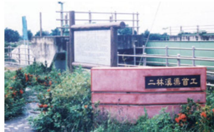
▲ 二林溪渠首工。
