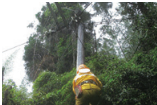
▲ 阿里山服務所同仁正在檢修玉山幹線的電杆情形，山裡各種檢修工作，不只是工作當下的困難，有時甚至連要搬運材料前往施工地點都是一大難題。
