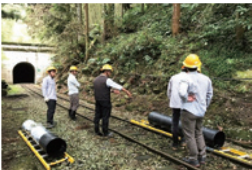
▲ 利用林鐵搬運複合式分節電桿的景象，是僅屬於阿里山才有的台電檢修特色。
