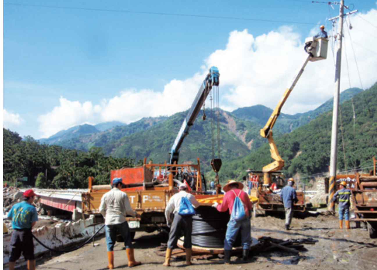
▲ 莫拉克災後搶修初期，大型工程車無用武之地，直到道路搶通，才能仰賴升空車接續施作永久的架線工程。
