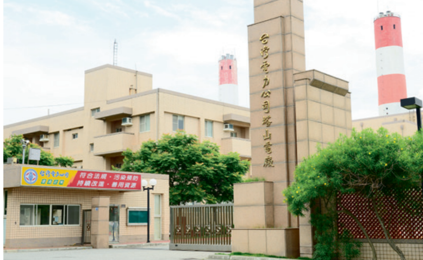
▲ 塔山發電廠，是金門邁入大電力時代的重要里程碑。（塔山發電廠提供）。
