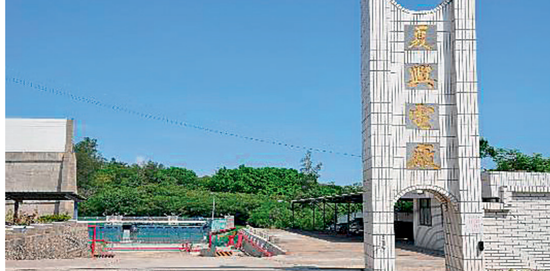
▲ 台電公司夏興發電廠。
