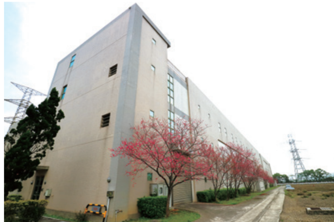
▲ 盛開的八重櫻點綴 345 仟伏屋內式北開關場建築，八重櫻是龍潭超高壓變電所綠美化政策的亮點成果。
