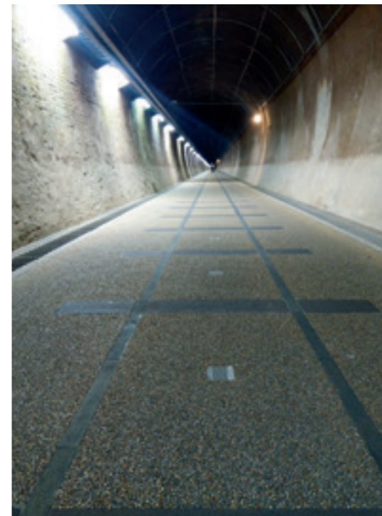
▲ 舊草嶺隧道內鋪平坦的地面，非常適合騎行。
