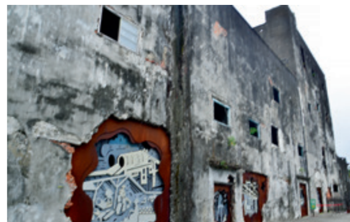
▲ 老廠房的建築的外牆變身為裝置藝術。
