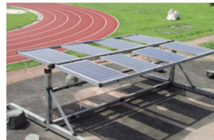
▲ 張校長結合業者在蘇澳國中校園操場設置的太陽能追日系統，可隨日照時間調整角度。
