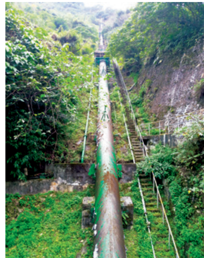
▲ 孫運璿先生曾順著清水第二發電所的鋼管路階梯，徒步進入清水發電廠。
