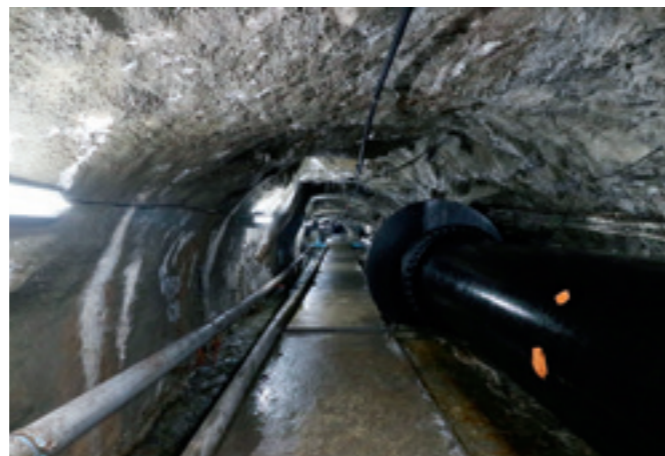
▲ 龍澗發電廠廠房廊道，自海拔 1,276 公尺的冷風灌入海拔 384 公尺的隧道內，就算在夏季都能感受到高山的冷澈。
