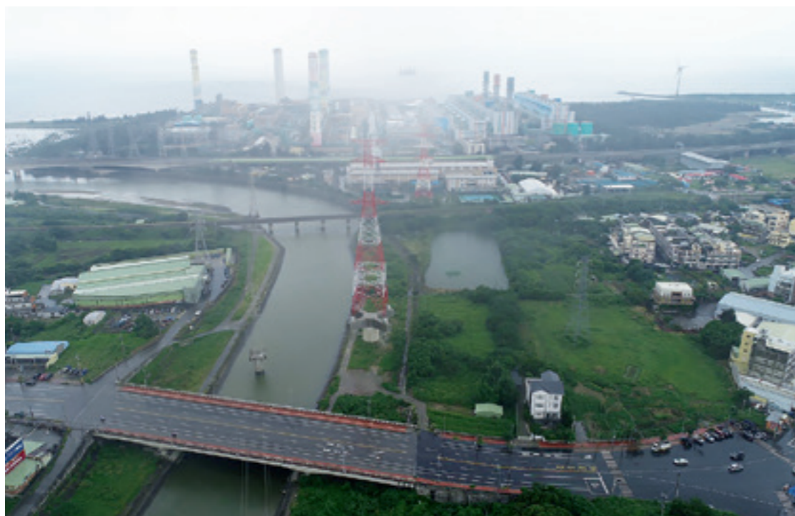
▲ 從通霄發電廠延伸出的通霄義和高壓線路。
