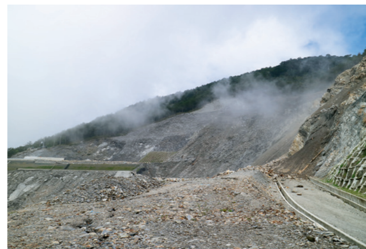
▲ 臺 20 線的 148 公里處大崩壁，是民國 98 年八八水災至今未能復原的後遺症，連帶嚴重影響利稻分線的檢修工作。
