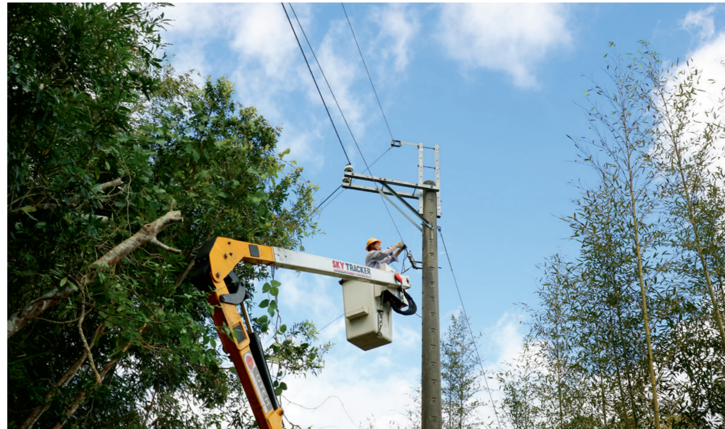
▲ 搭乘升空車進行利稻分線低壓線斷線修復的關山服務所同仁，偏遠山區相對交通與醫療更為不便，因此落實工安意識不僅維護台電形象，更是保護自身性命安全的不二法門。
