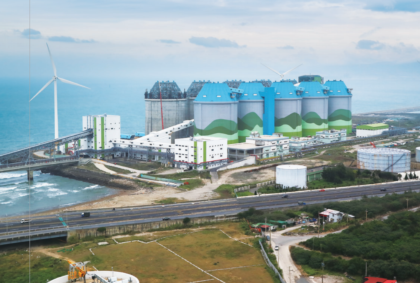
▲ 台電利用林口一期灰塘興建首次引入技術的筒式煤倉，讓煤碳粉粒飄散問題一勞永逸。右方儲槽就是發現臺灣百合蹤跡的重油儲槽。
