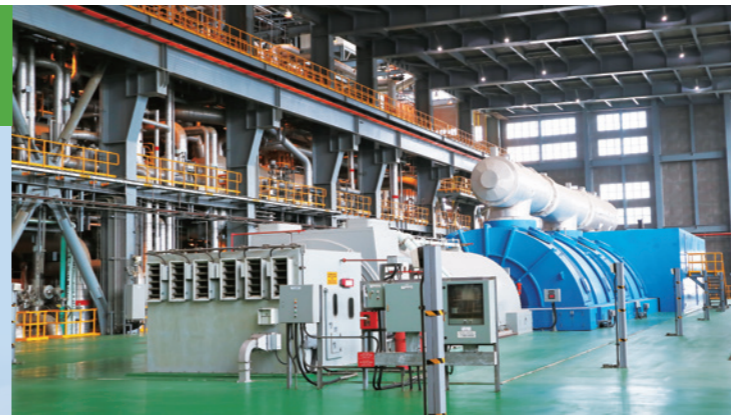
▲ 林口發電廠超超臨界燃煤機組 1 號汽輪機，在最新進的環保技術支持下，空汙防制已接近燃氣發電廠的標準。
