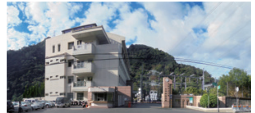
▲ 大甲溪發電廠的大門口。
