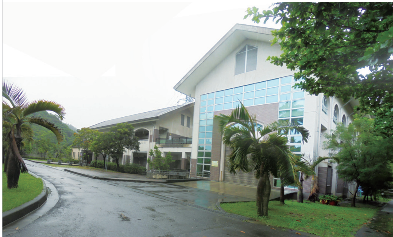
▲ 竹門電廠新發電廠房 (右) 新辦公室 (左)。
