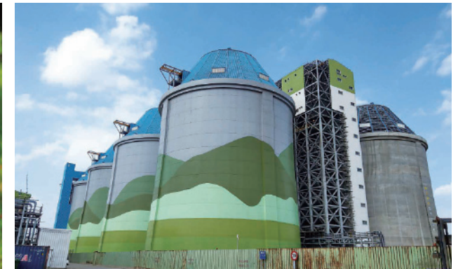
▲ 林口發電廠的室內煤倉。
