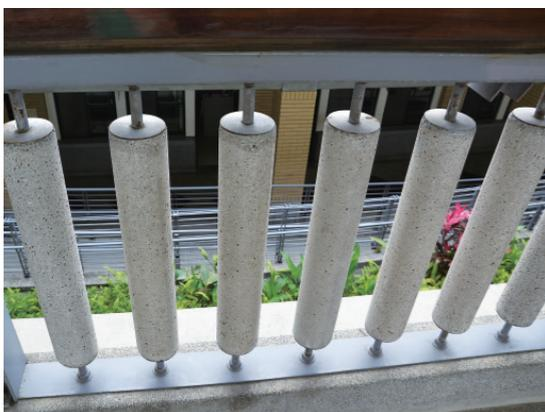
▲ 迴廊女兒牆的圓柱護欄是零碎水泥塊壓碎後塑造成的，屬於綠色再生建材。
