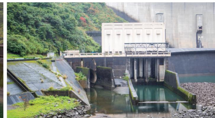
▲ 翡翠發電廠尾水出口與照片左方的排洪隧道出口。
