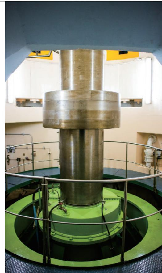
▲ 水車室中連接下方水輪機與上方發電機的軸承。
