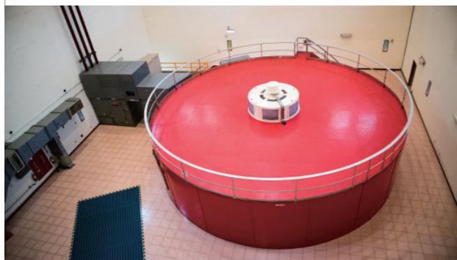
▲ 額定 77,778MVA 的發電機組，為北臺灣單機容量最大的水力發電機。
