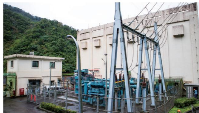
▲ 翡翠發電廠的開關場，發電機發出的電力經由此輸送至台電的輸電網路中。
