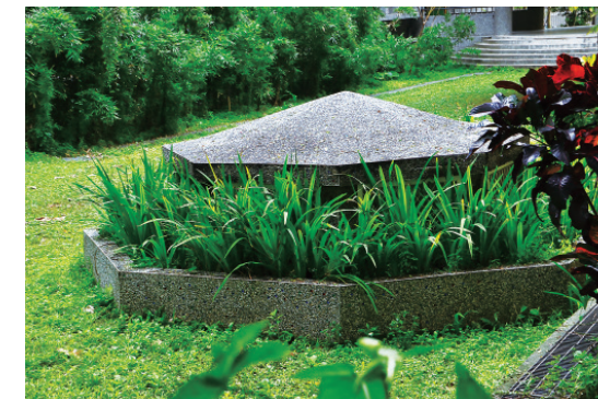
▲ 看似花園的建築，其實是地下室的通風口。
