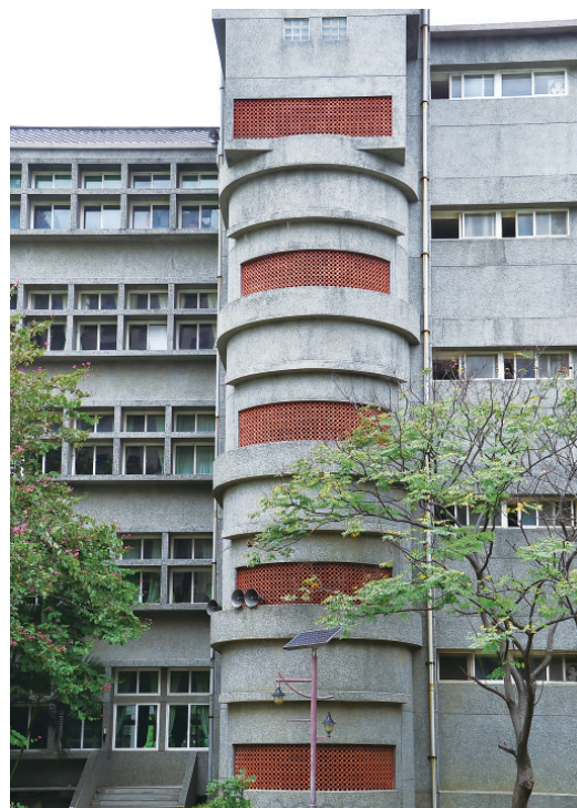
▲ 運動場的夜間照明也是靠太陽光電板。
