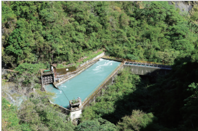
▲ 義興發電廠兩段輸水隧道之間的匹亞溪沉砂池，呈現精巧的「之」字形流水。
