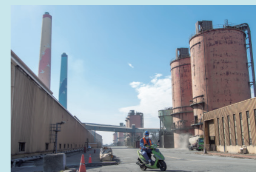
▲ 台中電廠排煙脫硫設備。
