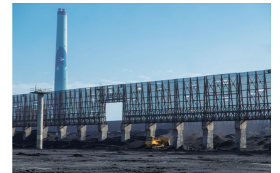
▲ 防風網可降低風速，減少露天煤場的揚塵。
