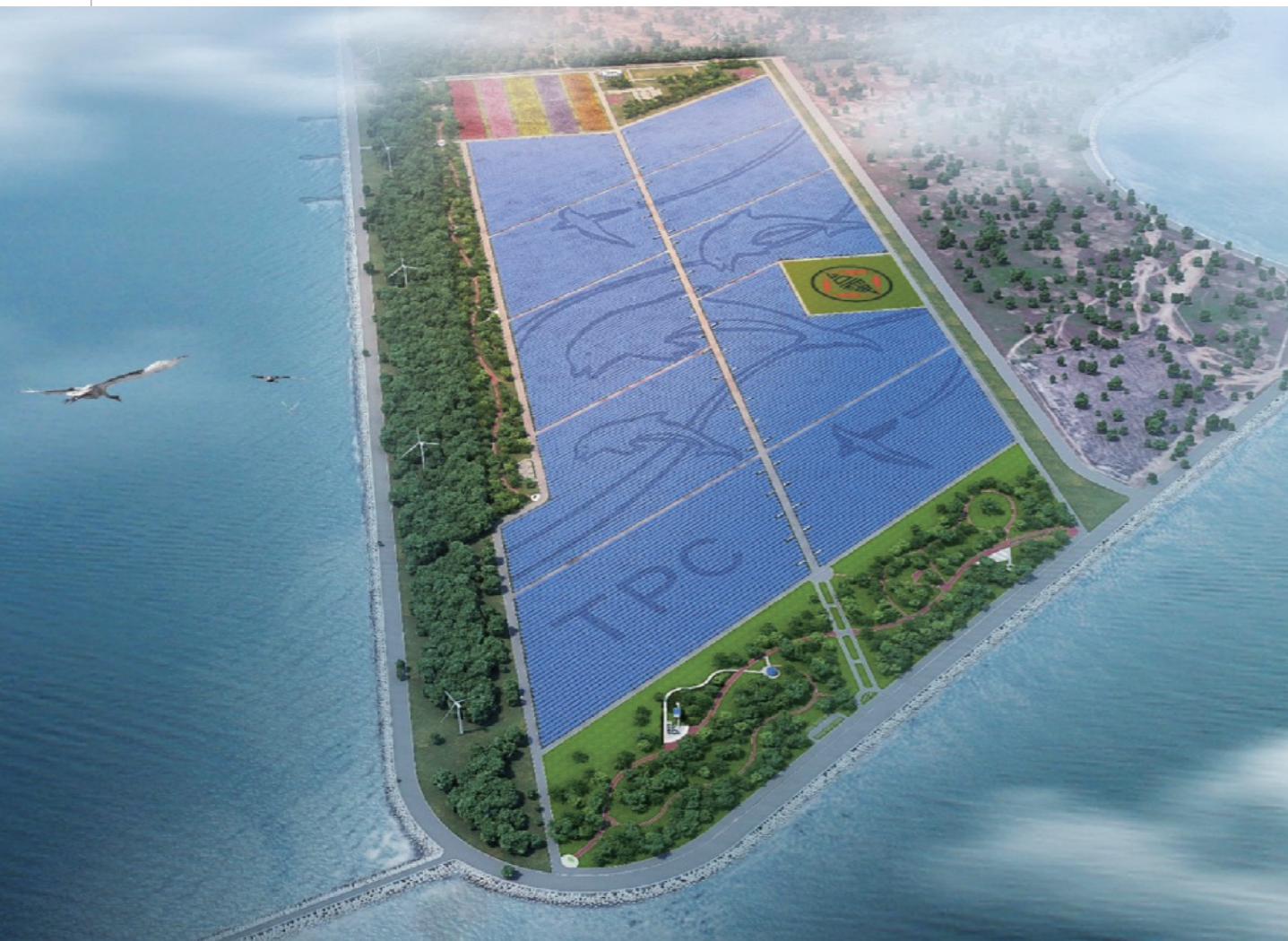
▲ 結合白海豚及小燕鷗意象的太陽能光電板 (圖片摘自再生能源處工程施工規範)。
