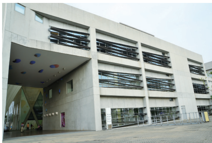
▲ 圖書館外牆的大片玻璃窗加裝了Z字形斜階的外框，既有防風的安全功能，也起到遮陽防曬的作用。
