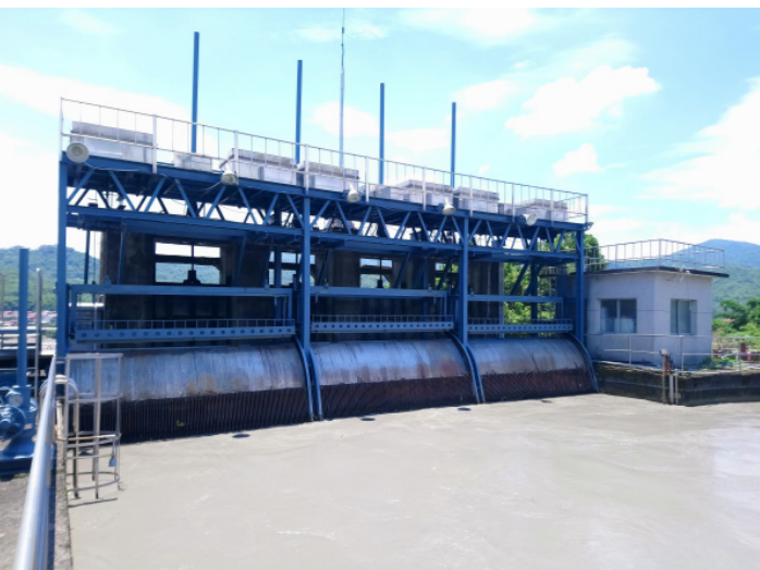
▲ 土壠灣發電廠的前池，在水進入機組前，會先透過攔汙柵將大型的石頭與枯木阻隔，以確保機組運轉安全。
