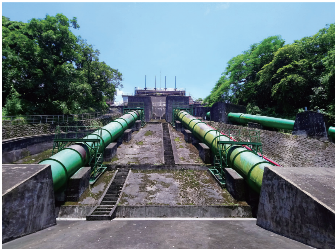
▲ 兩條碩大的壓力鋼管，分別供應給一號與二號機發電之用，另外在照片右方則是水量太多時的餘水路。
