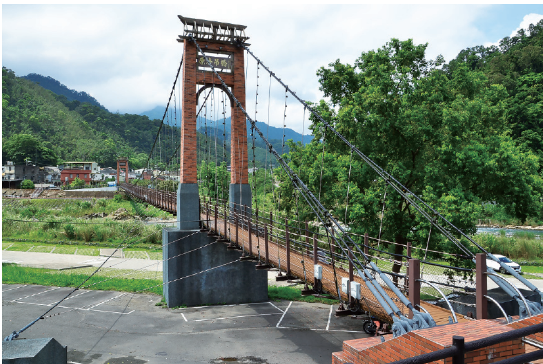
▲ 橫跨中港溪的康濟吊橋是南庄的標誌。
