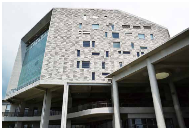
▲ 圖資館清水模外牆在施作時用保麗龍板，不同於一般的木板施作，而產生特殊的紋理效果。
