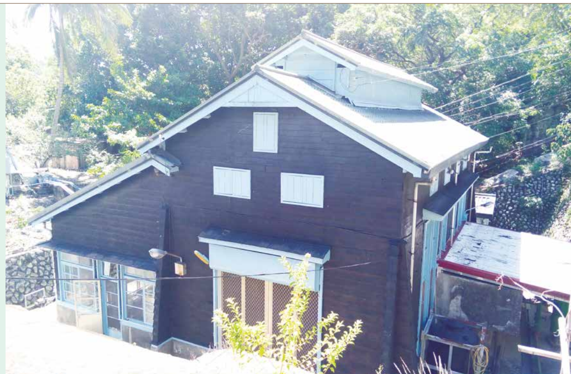
▲ 西元 1942 年完工至今仍可使用的發電所廠房。
