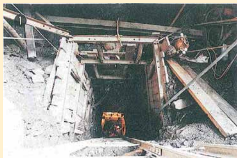
▲ 龍溪發電廠壓力鋼管斜坑開挖作業。
