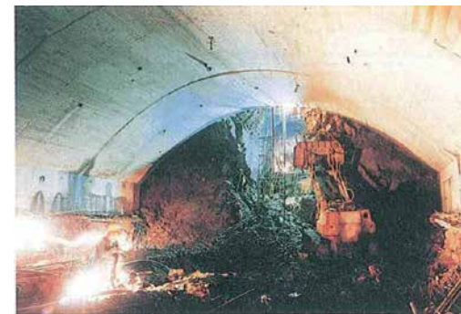
▲ 地下廠房的開挖作業，可看見穹頂已施作完成。
