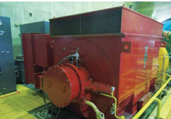
▲ 臺灣少見的感應式發電機，由日本製造但由臺灣自行安裝成功。
