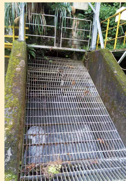
▲ 奇萊引水隧道的出口，匯集了木瓜溪上游五條支流清澈的溪水注入到龍溪調整池中。
