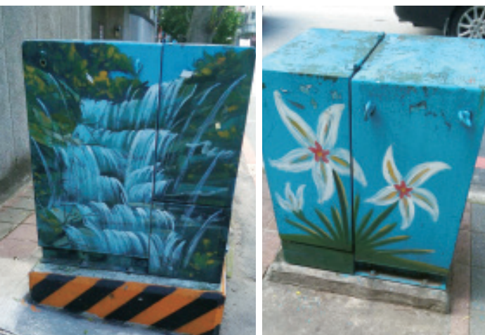
▲ 電力設備有金屬外殼隔絕，幾乎沒有電場。
