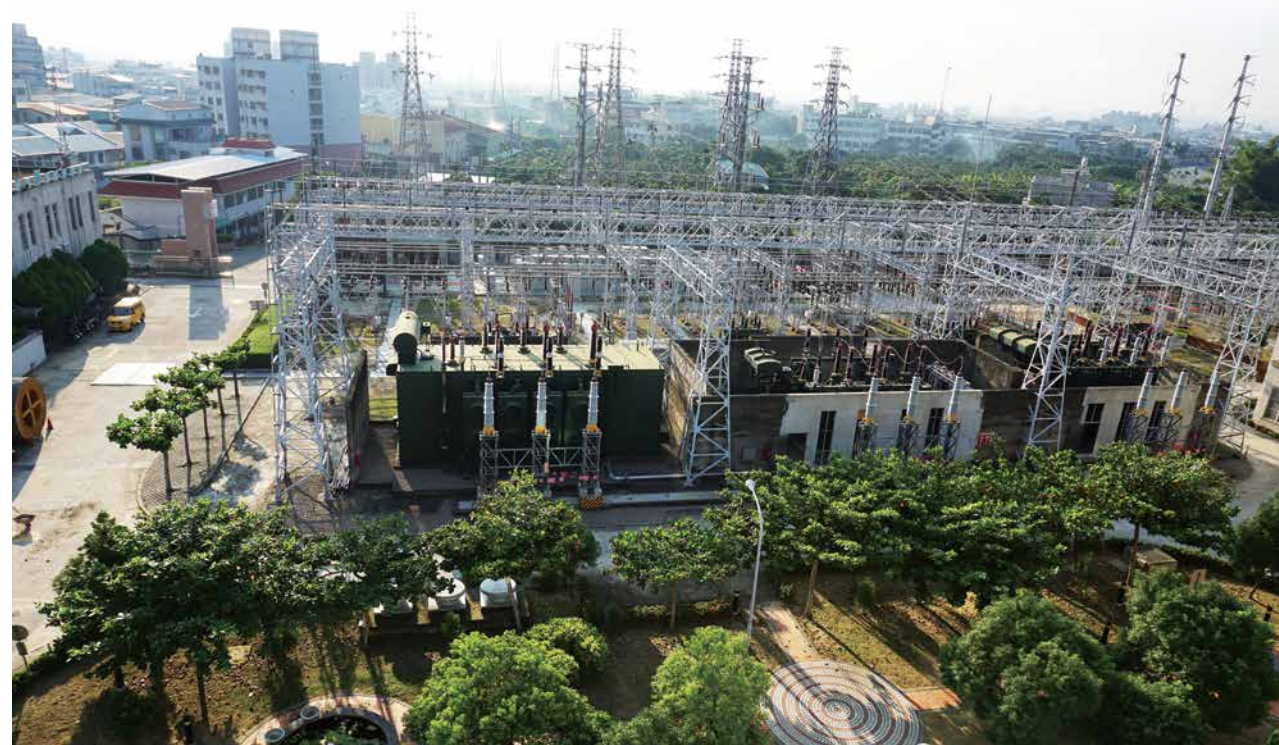
▲ 霧峰變電所攸關中部供電穩定
