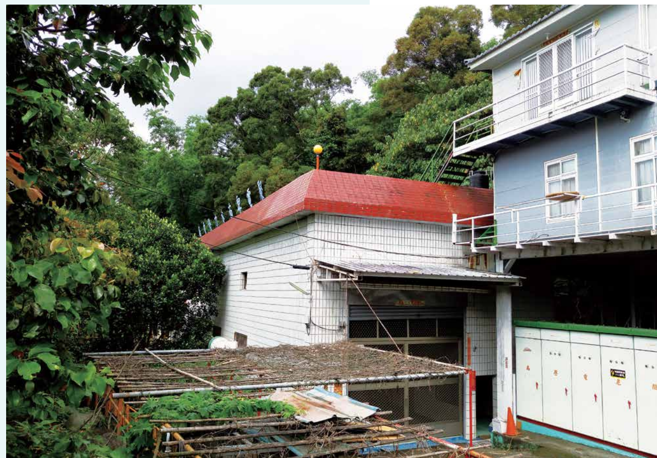
▲ 卑南上圳發電廠廠房外觀
