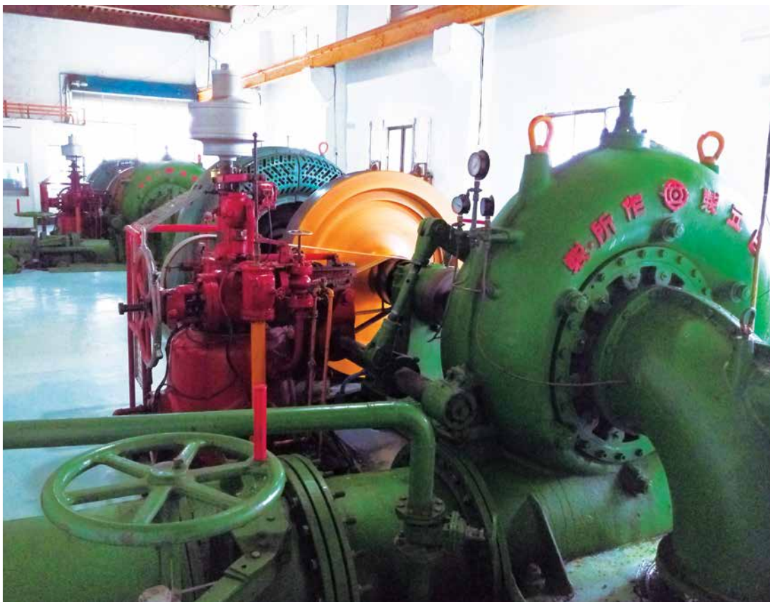
▲ 卑南上圳發電廠機組側寫
