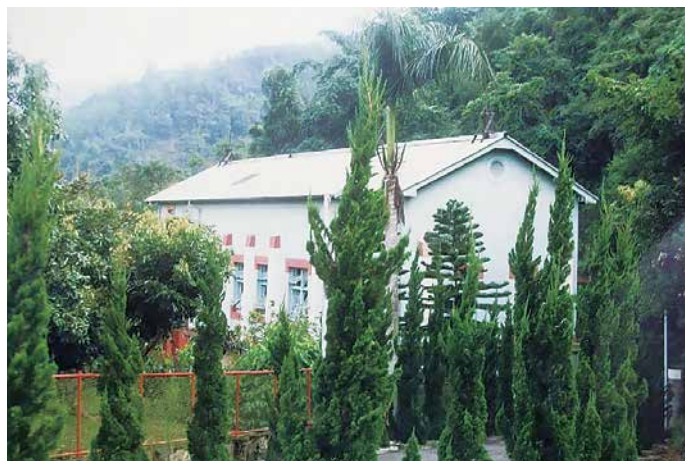
▲ 北山發電廠改建前廠房
