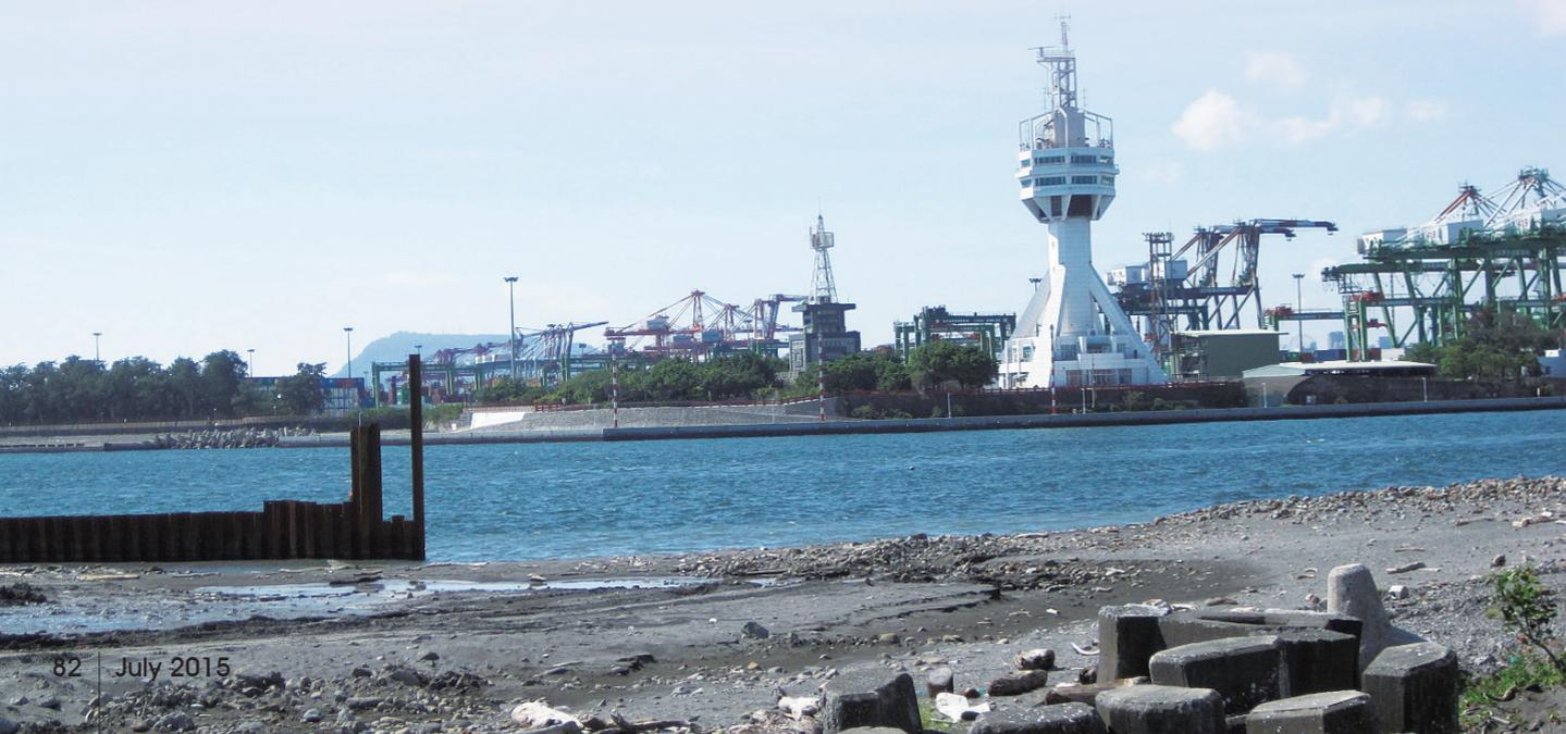
註 大林發電廠前所用以發電用的煤料，係由裝載進口煤炭之船舶，泊靠於第 111 號碼頭並將煤炭先卸移至位於電廠西北端約 1.4 公里處，面積達 26 公頃之露天儲煤場，再藉由長達 1,409 公尺之運煤皮帶機，將煤炭輸送至大林發電廠的鍋爐處以燃燒發電。
