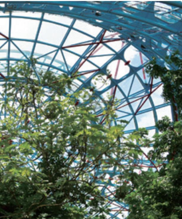
採高精密密度（誤差值 1/1000）的圓形鋼架結構，外牆帷幕則以懸吊式玻璃組成，主要構架以 6 組擱抗結構的塔柱來支撐，自上而下是兩層的圓形屋頂和 7 層的環梁構成空間桁架結構系統。
