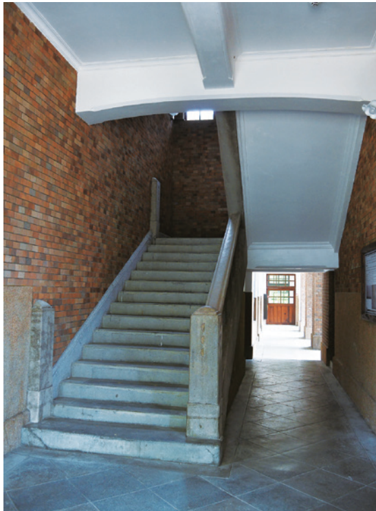
廳舍內部天花板為白灰木摺漆噴塗，壁面貼十三溝面磚可防水。
