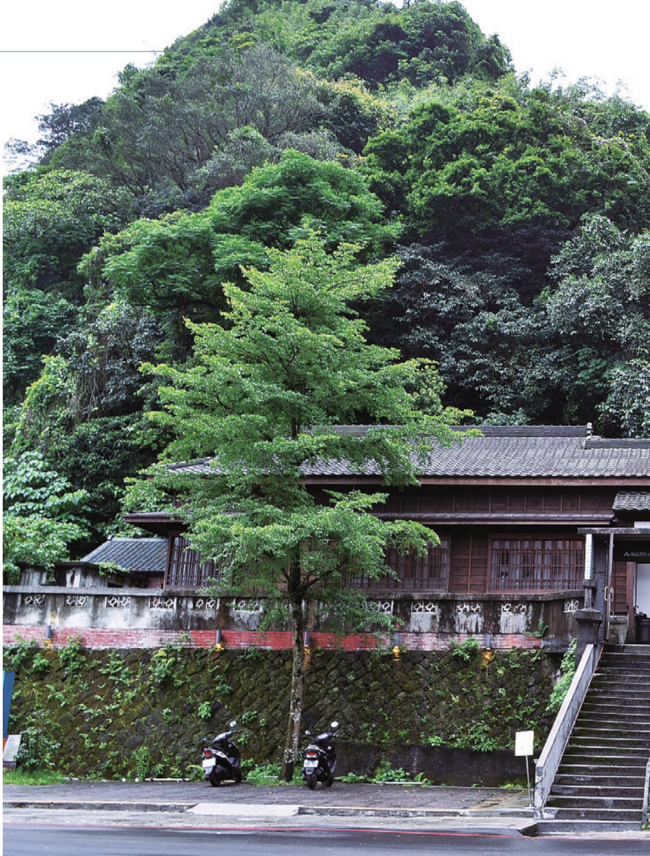
位於半山壁上的基隆要塞司令部是一處構造精緻的日式木造建築。
