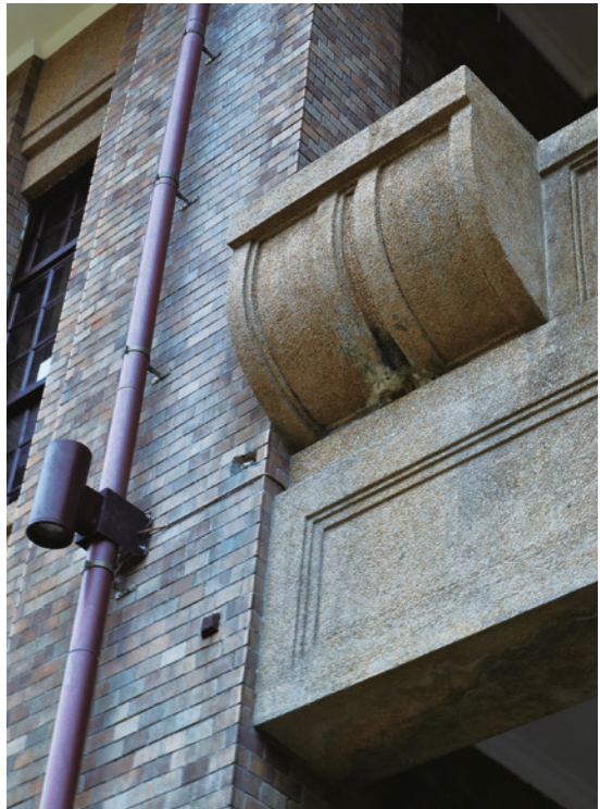
廊道牆體以洗石子裝飾，重點部位則以「泥塑洗石子」匠藝施作弧形收邊裝飾細部美感。
