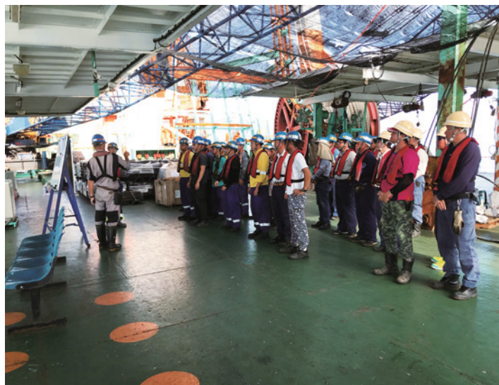
海纜修復之海事工程工作前的工具箱會議。
