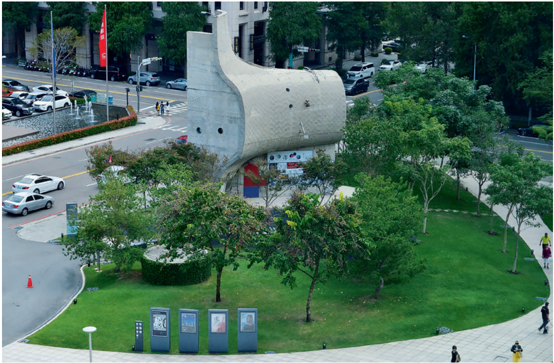
▲ 劇院外廣場一隅有一處被綠樹掩映的水泥牆體，就是當初建造時先行完成的曲牆初胚（粗胚），現在則作為一件公共藝術作品永久保存。
