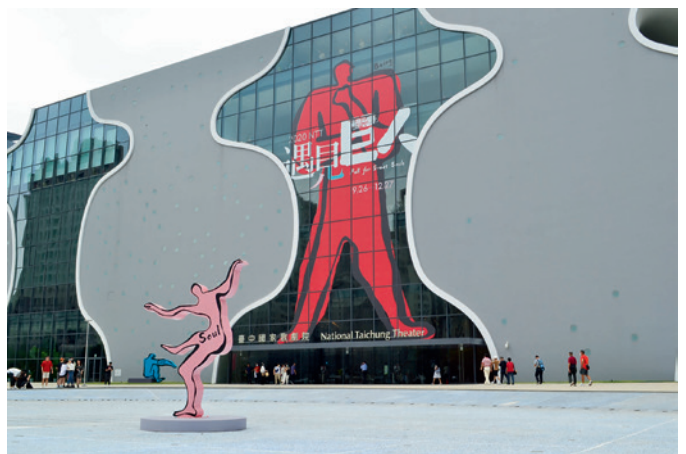
▲ 臺中國家歌劇院以其獨創的建築工法（曲牆建築工法和水幕防火設計）獲得民國 104 年國家建築「金質獎」。
