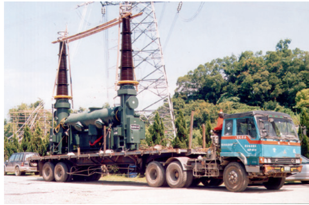
▲ 災後搶修，從四面八方借調備品投入使用加速復電速度。
