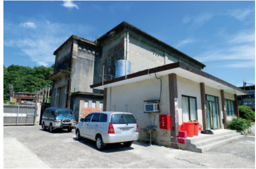
▲ 基隆二次變電所控制室新舊建築一前一後的相互照應，看得出建築設計結構與外觀的不同。
