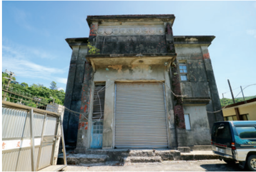
▲ 瑞芳變電所舊控制室，外牆雖已斑駁老朽，但仍可見早期日本人對建築美感的要求。
