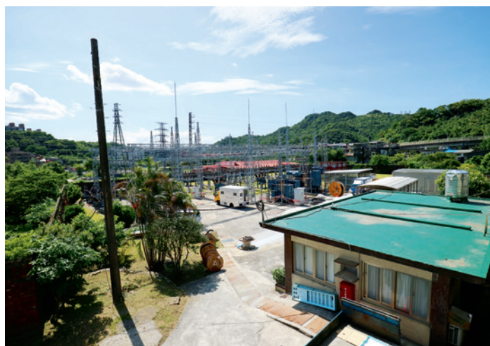
▼ 因日本人預留的土地面積足以直接興建新變電所，陰錯陽差地將舊變電所完整保留，留下珍貴的台電文資。
