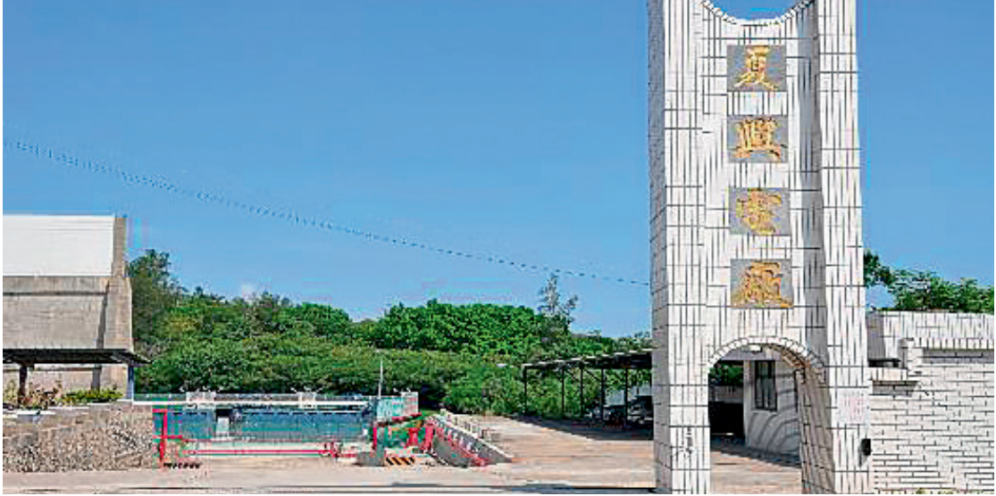
▲ 台電公司夏興發電廠。
