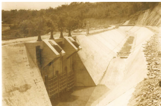
▲ 石門大圳第二工區虹吸洞及支渠。(經濟部北區水資源局提供，游常山翻攝)
