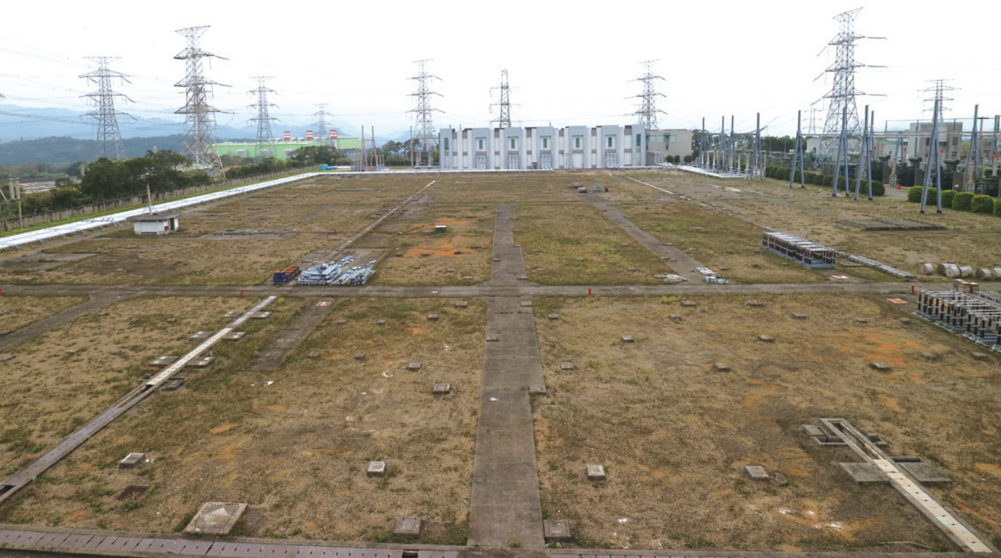
▲ 舊屋外式 345 仟伏北開關場改建後留下的廣大土地，原作為高原計畫的用地，在高原計畫暫緩實施後，預計將改為 345 仟瓩的大型儲能場。
