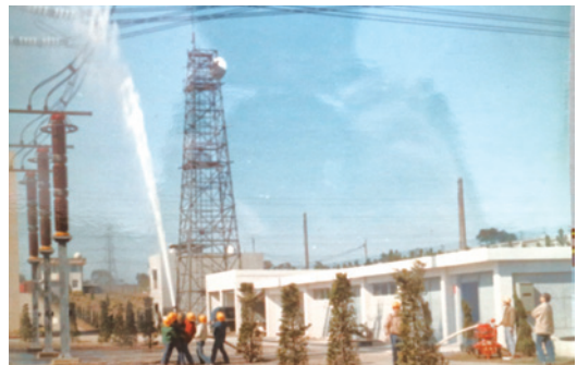
▲ 利用高壓水柱清掃礙子中的龍潭超高壓變電所同仁，早期鹽霧害嚴重時，三番兩次的洗礙子工作幾乎成為變電所同仁的家常便飯。（新桃供電處提供，鄧宗文翻攝）
