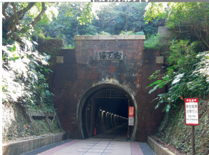
▲ 舊草嶺隧道北端「制天險」題字。
