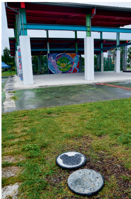
▲ 腳踏車輪胎踏石，鋪在校園草地上當作步道，既美觀又耐用，而且是可搬動的步道，對於當地多雨的氣候來說，再實用不過了。
