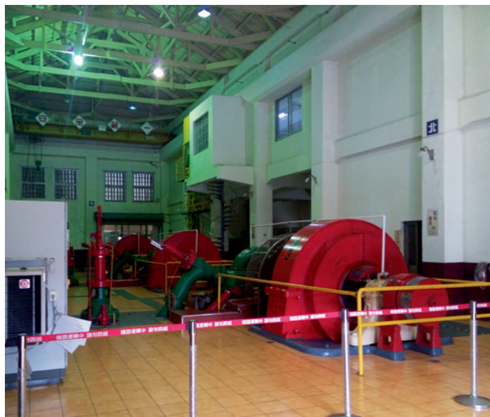
▲ 清水發電廠中三部橫軸佩爾頓水輪發電機，是日治時期花蓮港蓬勃發展與戰後百廢待興的重要功臣。
