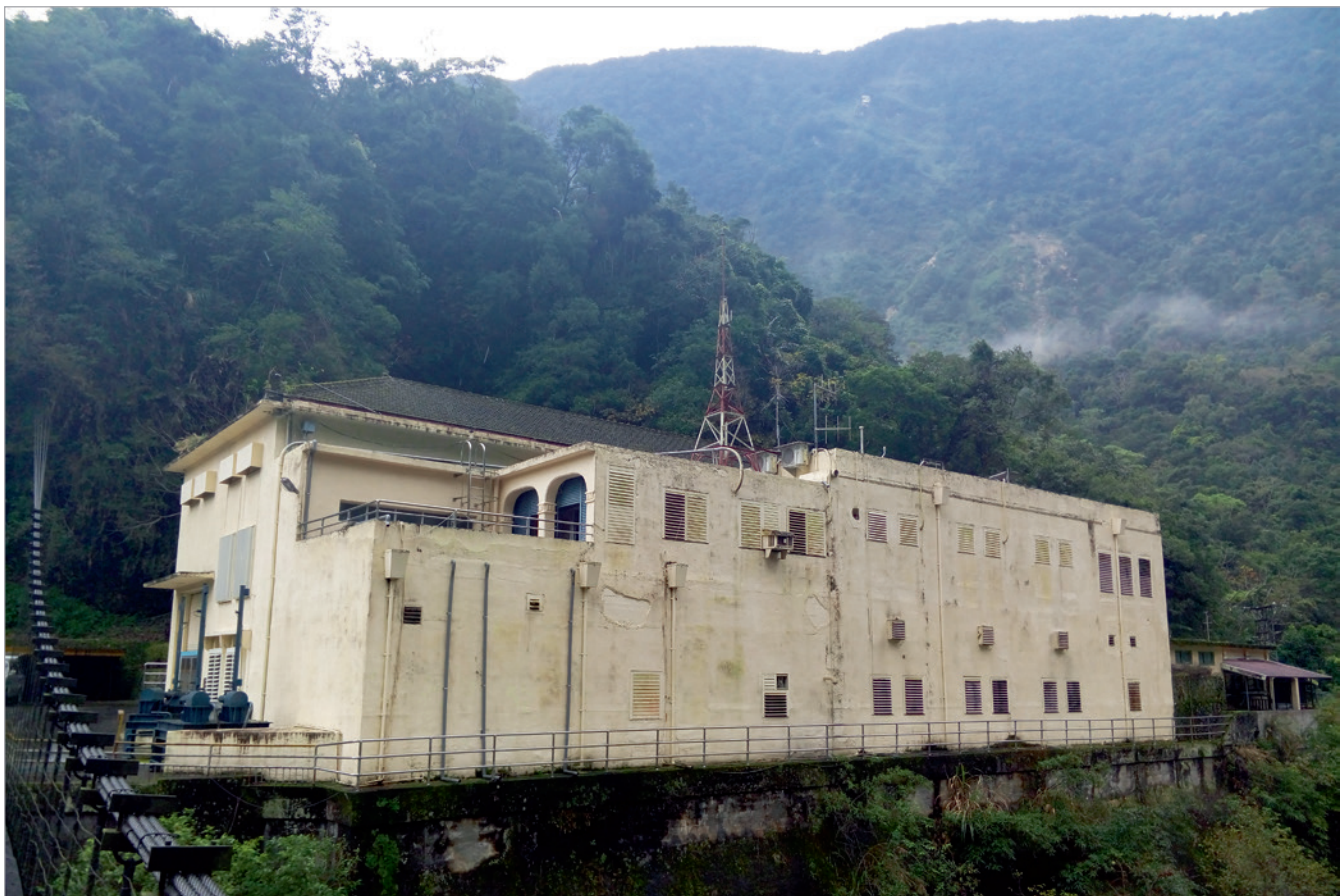
▲ 80年不變的清水發電廠，是東部地區最元老的水力發電廠。
