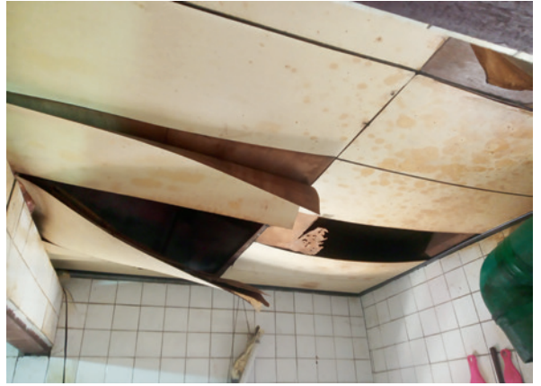
▲ 台電咁仔店志工暑假前夕到周奶奶府上訪視，發現天花板都已崩塌，屋內線路也老舊失修。
